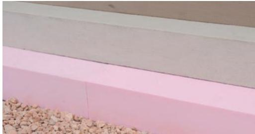
Druckfeste Wärmedämmplatte aus extrudierte
