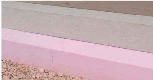
Wärmedämmplatte aus extrudiertem Polystyrolhartschaum für höchste Druckbelastung mit **Stufenfalte (SF)**
