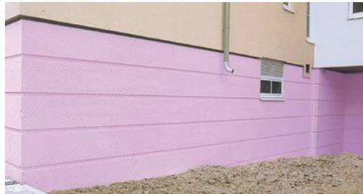
Druckfeste Wärmedämmplatte mit verbesserten Wärmedämmegenschaften aus extrudiertem Polystyrolhartschaum im Thermobonding Verfahren mit geprägter Oberfläche und gerader Kante
