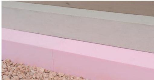
Druckfeste Wärmedämmplatte aus extrudierte
