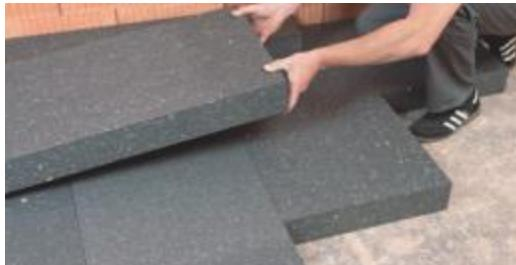
Hoch druckbelastbare höchstwärmedämmende Dämmplatte aus expandiertem Polystyrolhartschaumstoff
