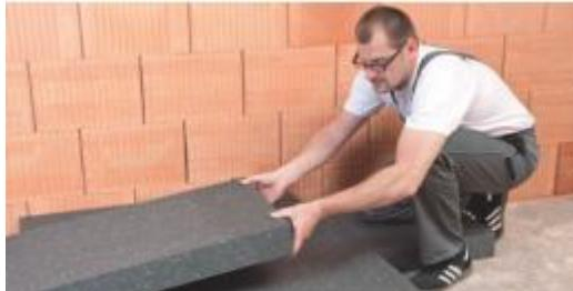
Druckbelastbare höchstwärmedämmende Dämmplatte aus expandiertem Polystyrolhartschaumstoff
