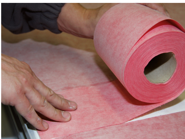
Anschließend wird Sopro AEB® Dichtband in das Kleberbett eingelegt und der Stoßbereich überklebt.
