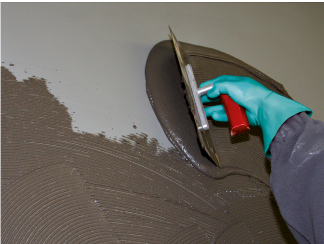
Aufkämmen von Sopro megaFlex S2 turbo mit der entsprechenden Zahnkelle. (Alternativ kann zur Bahnenverklebung auch FDK 415 oder DSF RS aufgerollt werden)
