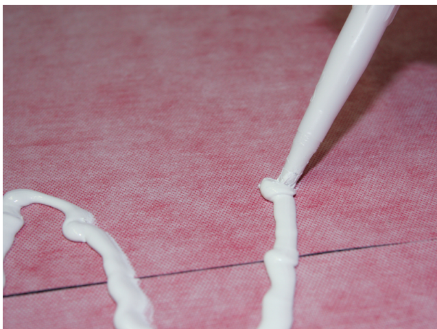
Im Stoßbereich Sopro Racofix® Montagekleber etwas breiter als Sopro AEB® Dichtband (120 mm) schlangenförmig auftragen ...
