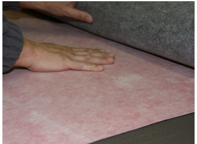
Die passgenau zugeschnittenen, einzelnen Bahnen der Sopro AEB® plus werden mit der grauen Seite nach unten vollflächig in das frische Klebebett eingelegt.
