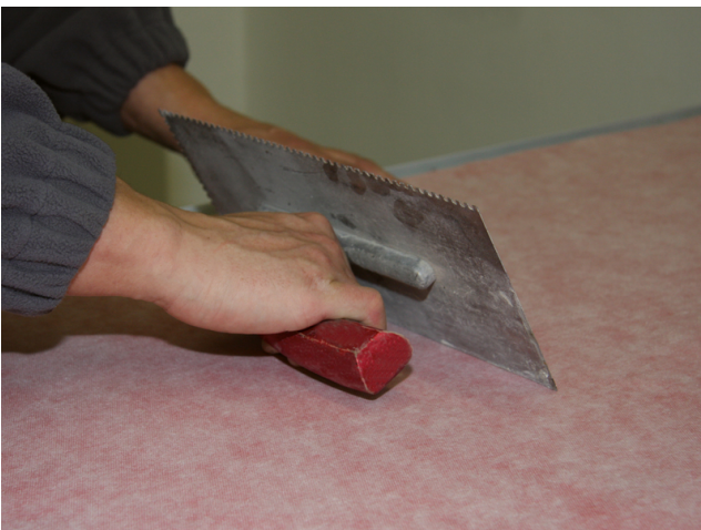
Mit Glättkelle oder Malerrollenbügel die Sopro AEB® plus andrücken und so abstreichen, dass keine Lufteinschlüsse unter der Bahn verbleiben.
