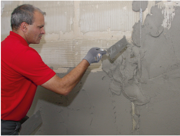
Die Fläche zwischen den Putzschienen durch Anwerfen von Sopro RAP 2® mit Putz füllen.
