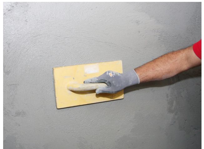
... oder einer Holzscheibe nachgerieben werden, um so besonders glatte Oberflächen zu erzielen.
