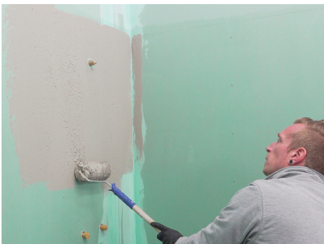
Sopro Fixier- & DichtKleber oder Sopro DichtSchlämme Flex RS vollflächig aufrollen.
