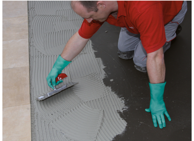
Auftragen des zweikomponentigen Flexklebers Sopro megaFlex S2 oder Sopro megaFlex S2 turbo auf die ausgehärtete Abdichtung.
