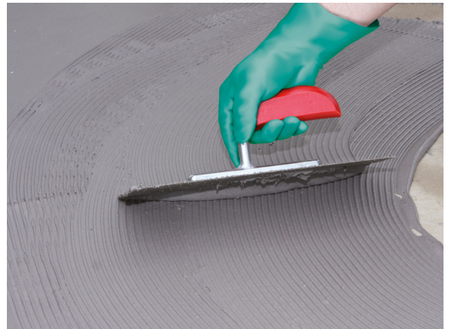
Aufziehen der Sopro TurboDichtSchlämme 2-K auf den angefeuchteten bzw. grundierten Untergrund mittels 4 mm-Zahnpachtel.
