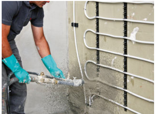
10. Sopro RAP 2® kann auch maschinell im Spritzverfahren aufgebracht werden – wie hier zur Einbettung einer Wandheizung (Kermi x-net c21).
