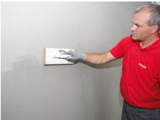
11. Der sauber abgezogene Putz kann nach 6 Stunden mit Fliesen belegt werden. Sollte keine Fliesenverlegung gewünscht sein, kann Sopro RAP 2® zusätzlich mit einem leicht angefeuchteten Schwammbrett ...
