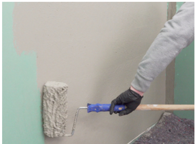
5 Für ein gleichmäßig deckendes Ergebnis Sopro Fixier- & DichtKleber oder Sopro DichtSchlämme Flex RS im Kreuzgang auftragen.
