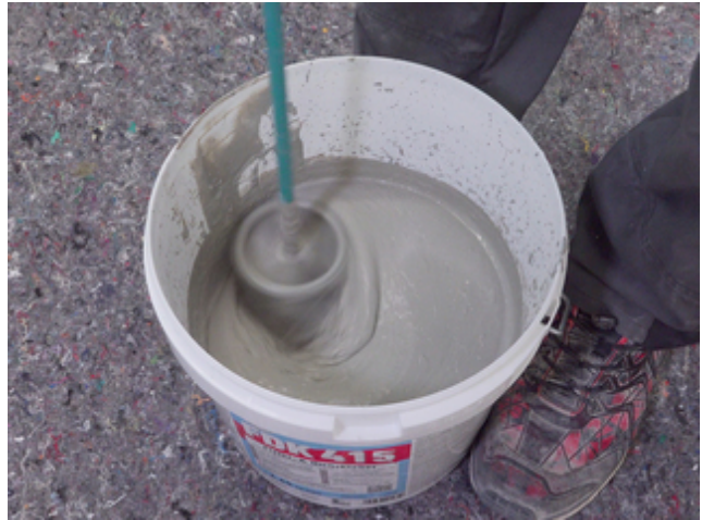
2 FDK 415: Flüssigkomponente vorgeben und mit Pulverkomponente maschinell anmischen. Alternativ: DSF RS im vorgegebenen Verhältnis mit Wasser anrühren.
