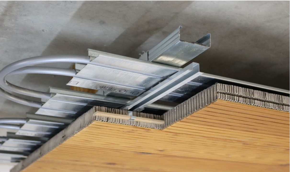
Die Abbildung zeigt den Aufbau Acoustic Premium mit Hutprofil und Systemkralle:
