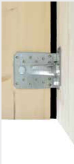
Gemessener Aufbau – mit Winkelverbinder und Schrauben
