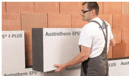
Höchstwärmedämmende Fassadendämmplatte aus expandiertem Polystyrolhartschaumstoff mit **Protect-Beschichtung**
