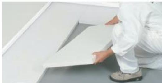
Trittschalldämmplatte aus expandiertem Polystyrolhartschaumstoff für Gesamtbelastungen bis 650 kg/m<sup>2</sup>
