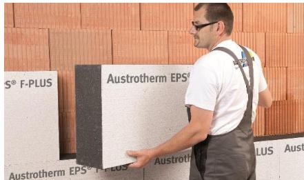
Höchstwärmedämmende Fassadendämmplatte aus expandiertem Polystyrolhartschaumstoff mit **Protect-Beschichtung**
