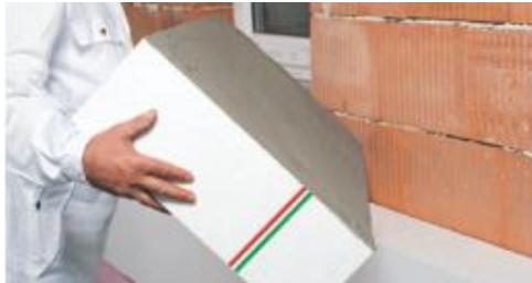
Schall- und wärmedämmende Fassadenplatte aus expandiertem Polystyrolhartschaumstoff
