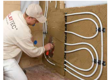
Der Unterputz wird über die Rohrscheitel abgezogen
