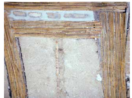
Rohrgewebe St70 auf Holzbalken einer Fachwerkwand
