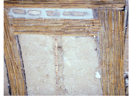
Rohrgewebe St70 auf Holzbalken einer Fachwerkwand
