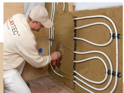
Der Unterputz wird über die Rohrscheitel abgezogen
