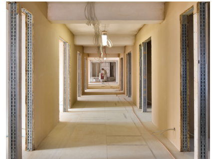
Lehm-Dünnlagen Beschichtung beim BV UN-Campus, Bonn
