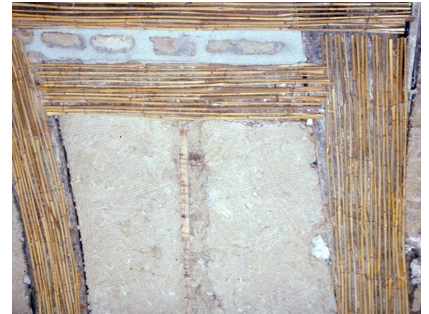
Rohrgewebe St70 auf Holzbalken einer Fachwerkwand
