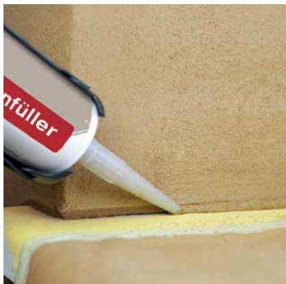
Fugenfüllung mit natur-braun an einer Fensterbank
