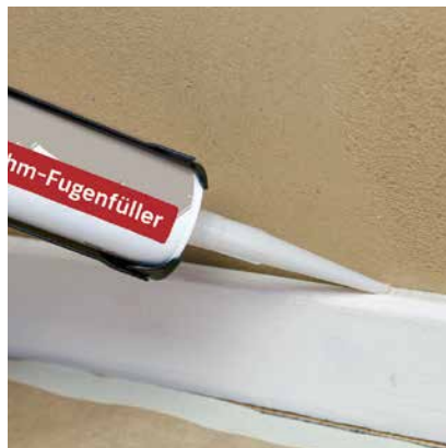
Fugenfüllung mit natur-weiß an einer Sockelleiste
