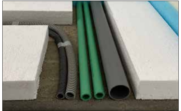
Installationsebene mit Dämmplatten des Anwendungstyps DEO auslegen
