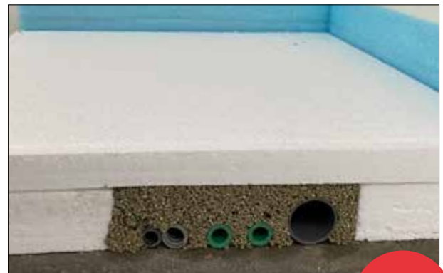
Darüber liegende Dämmschicht auslegen, dabei die Schüttung nicht betreten
