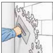
1. Der Untergrund muss trocken, tragfähig, sauber und glatt sein. Alte Tapeten und nicht haftende Beschichtungen entfernen. Rauе Untergründe mit gipshaltigen Spachtelmassen glätten. Durch geeignete Grundiermittel für einen gleichmäßig saugenden Untergrund sorgen.
