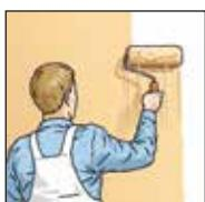
6. Die ERFURT Vliesfaser Premium ist vorgestrichen. Nach dem Tapezieren ist kein Anstrich erforderlich. Die Fertig-Tapete kann im Bedarfsfall mit einer geeigneten Farbe, idealerweise einer Dispersionsfarbe (mind. Nassabriebsklasse 3 nach DIN EN13300), beschichtet werden.
