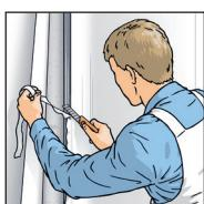
7. An Außenecken wird nicht überlappend tapiziert, sondern die Trennung erfolgt exakt auf der Kante.
