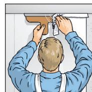
6. Die Trennung in den Ecken wird mit der Schere ausgeführt. Alternativ kann die Rauhfaser in den Ecken auch an einem Tapezierspachtel gerissen werden.
