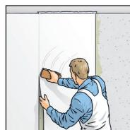
5. Die Bahnen Naht an Naht im Lot verkleben. Blasen- und faltenfrei mit Tapezierbürste oder Gummimolle andrücken.
