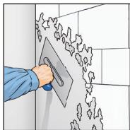
1. Alte Tapeten und Anstriche entfernen. Rauе Untergründe mit gipshaltigen Spachtelmassen glätten. Stark saugende Untergründe mit lösungsmittelfreien Grundierungen grundieren.
