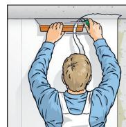
5. Überstände an Decken, Fußleisten, Fenstern usw. mit dem Cuttermesser und dem Tapezierspatel abschneiden.
