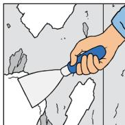
1. Alte Tapeten und Anstriche entfernen. Rau Untergründe mit gipshaltigen Spachtelmassen glätten. Stark saugende Untergründe mit lösungsmittelfreien Grundierungen grundieren.
