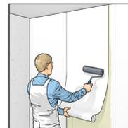
9. Klimaplatten sind ohne Armierung mit allen diffusionsoffenen Wandbelägen, Putzen und Beschichtungstoffen etc. überarbeitbar.
