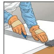
**3.** RapidBoard mit Cutter anritzen und über Kante brechen oder mit einer Säge zuschneiden.
