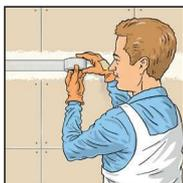
**7.** Die Plattenstöße werden mit dem Silikat-Spachtel und mit einem Fugenband armiert.
