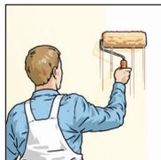
8. Klimaplatten mit Kleister grundieren (nur bei Tapezierungen).
