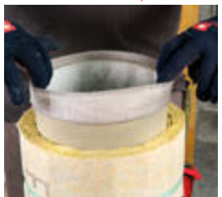
Bild 8a: Montage mit Gewebedichtung (15) (optional): Aufstecken auf die Rohrspitze
