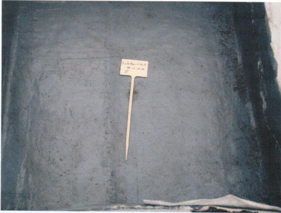
Abb. 1: Abdichtungsoberseite ohne Durchwurzlungen
