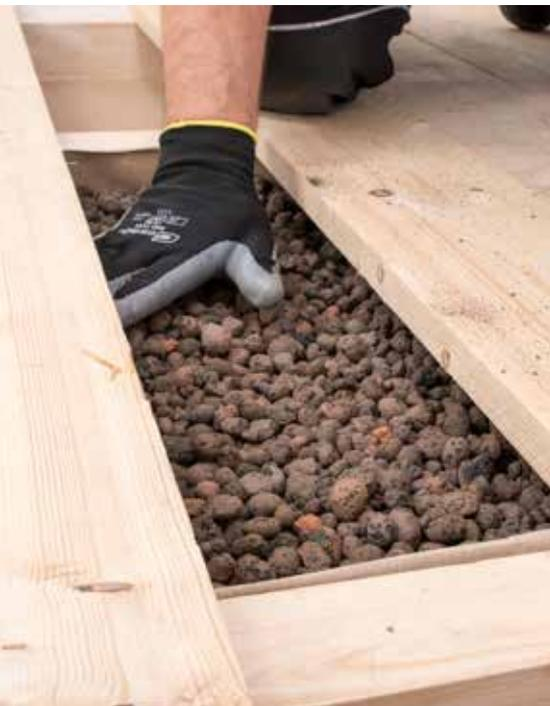
Die hier gezeigten Aufbauten\* für Holzbalkendecken sind im Grundaufbau identisch. Durch Einsatz und Kombination verschiedener Schüttungen sowie durch weitere Maßnahmen wie Trittschalldämmplatten, Gussasphaltestrich, anderen Entkopplungsmaßnahmen, Hohlraumdämpfung oder zusätzliche Masse können Schalldämmwerte und auch Feuerwiderstandsklassen erreicht werden, die sogar für den mehrgeschossigen Wohnungsbau interessant sind.
