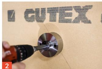
2 GUTEX Lochsäge HF-A mit geschlossenem Auswurfsystem ansetzen und mit mäßigem Druck bohren.
