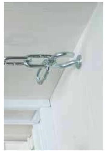
Kette mit Feder verbinden und am Haken im Lukenkasten einhängen. Für mehr Zugkraft der Feder einfach die Kette ein Glied weiter einhängen.
