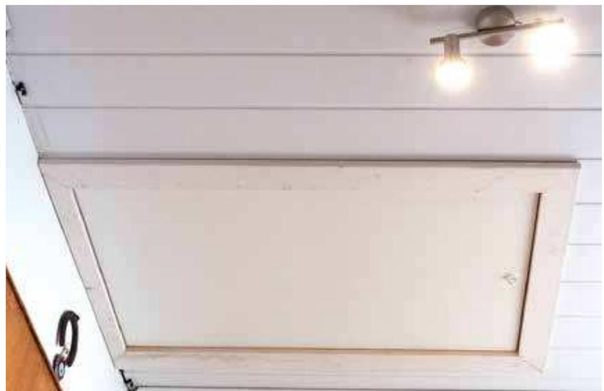
Die beiliegenden Abdeckleisten aus Kunststoff wurden auf Wunsch des Bauherren gegen Holzleisten getauscht. Kiefernholz ist gut geeignet. Beim späteren Lackieren scheint die Maserung nicht mehr durch. Alle Leisten werden auf den Lukenkasten genagelt.
