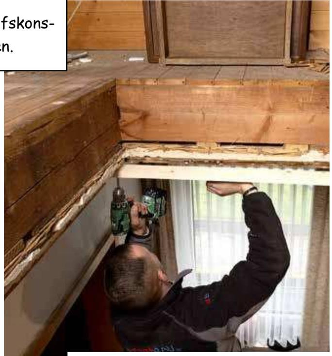
Alternativ Leisten mit einer Teleskopstange/Baustütze feststellen.
