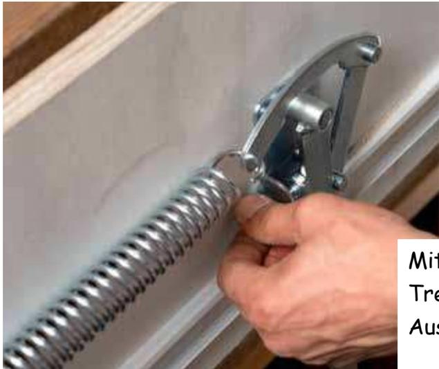
Mit der Stellschraube am Knickhebel die Ausladung der Treppe noch einmal korrigieren, sodass das Leiterenteil beim Aus- und Einklappen nicht an den Lukenkasten schlägt.
