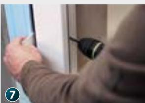
7. Fenstermontage entsprechend des RAL-Leitfadens zur Montage (z. B. mit unserem Hannoband®-3E BG1)<sup>3</sup>. Randabstand für Bohrungen zur Fenstermontage beachten: Mindestens 20 mm.
