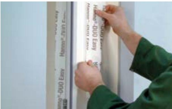
Das dehnfähige Hanno®-Folienband DUO Easy 240 ermöglicht mit seiner vollflächig selbstklebenden Unterseite einen einfachen Einbau. Zudem ist das Folienband komplett überputz- und überstreichbar.
