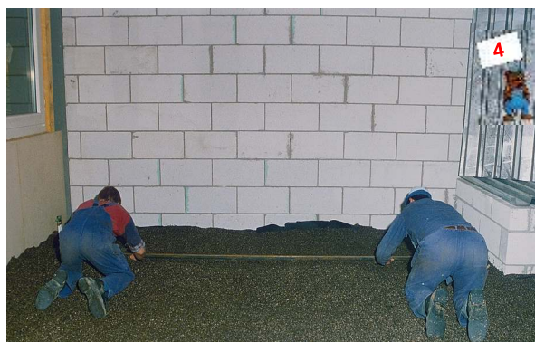
Oberflächenglattes Abziehen von VERMIBIT.
