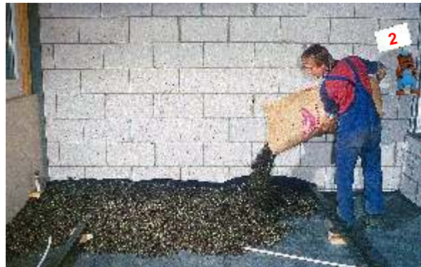
Schütten und verteilen, Mindesthöhe 20 mm.
