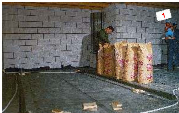
Setzen der Abziehlehren z. B. auf VERMIBIT.
