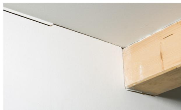
Überspringender Riss aufgrund fehlender Bauteiltrennung
