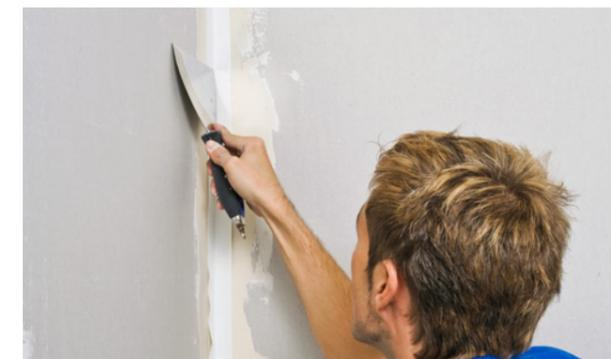
4. Mit Spachtel oder Traufel plan rechts und links des Falzes in die Spachtelmasse eindrücken.
