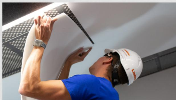
Die bewährte Unterkonstruktion für das Cleaneo Klett Board und die flächige Klettverbindung machen die Montage der akustisch wirksamen Cleaneo Klett Surface extrem einfach und jederzeit reversibel.
