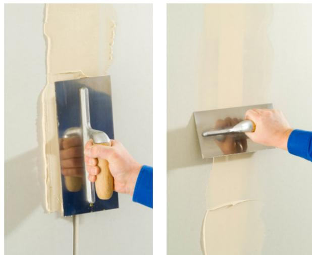
1. Eindrücken der Spachtelmasse quer zur Fuge. Mit Knauf Uniflott ist bei reiner HRAK Fuge kein Fugendeckstreifen nötig.
