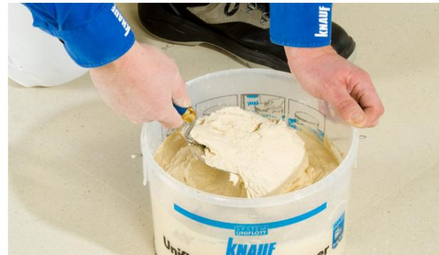
Das Spachtelmassenpulver sinkt dabei langsam auf den Eimerboden und saugt sich mit Wasser voll. Diesen Vorgang nennt man Sumpfen.
