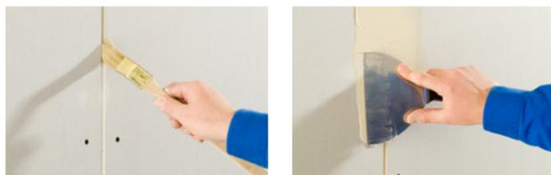
2. Fuge staubfrei machen. Vor dem Füllen den offenen Gipskern zur Staubbinding und Saugfähigkeitsregulierung grundieren (z. B. mit Knauf Tiefengrund).
