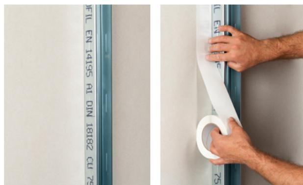
Profil auf angrenzendes Bauteil montieren und Trenn-Fix neben das Profil kleben
