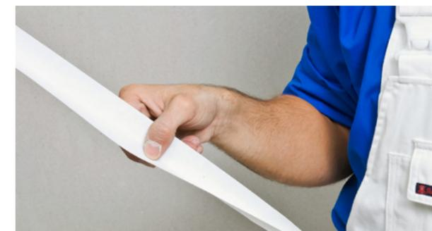
2. Fugendeckstreifen Kurt entlang des vorgefertigten Falzes knicken.
