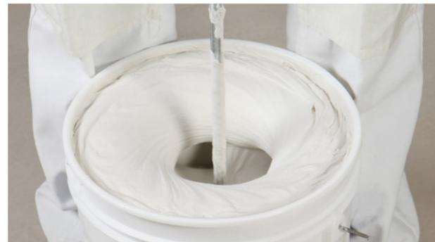
Nach dem Sumpfen wird die Spachtelmasse von Hand oder mit dem Mixer gut durchgerührt, bis sich eine sahnigsteife Konsistenz ergibt. Verwenden Sie beim Quirl große Korbdurchmesser bei niedriger Drehzahl.
