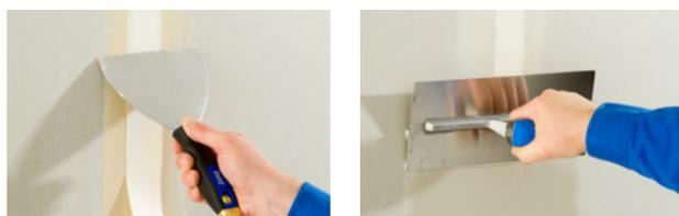
4. Einlegen des Fugendeckstreifens. Mit der Spachtel oder Traufel plan eindrücken sowie überschüssiges Material abziehen.
