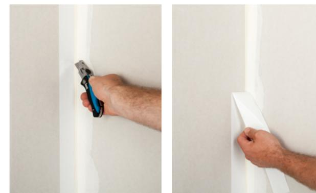
Nach Trocknung und Schleifen Trenn-Fix in der Ecke einschneiden und überstehenden Streifen abziehen
