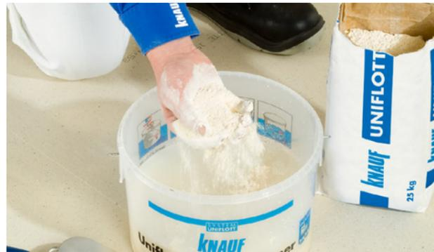
Füllen Sie den sauberen Eimer mit Wasser (Menge nach Herstellerangabe auf dem Gebinde). Streuen Sie das Spachtelmaterial möglichst klumpenfrei und gleichmäßig auf die Wasseroberfläche.
