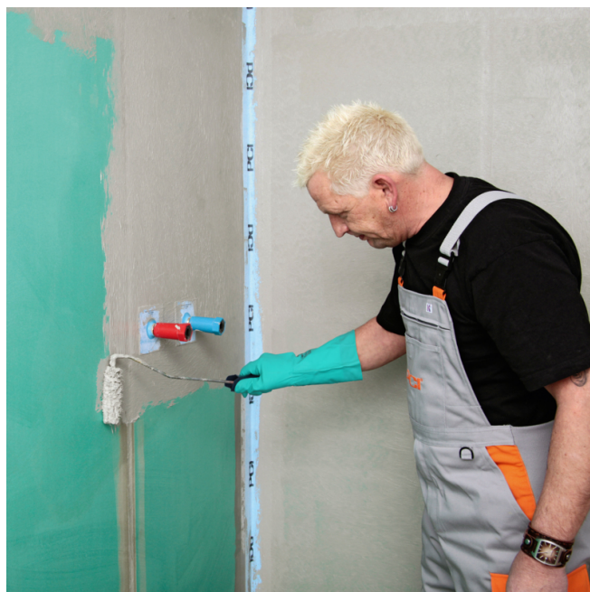
4. Schutzschicht mit PCI Lastogum Dicht unverdünnt satt und oberflächen-dicht auf den Untergrund auftragen. Nach der Trocknung Vorgang wiederholen und 2. Lage aufbringen.
