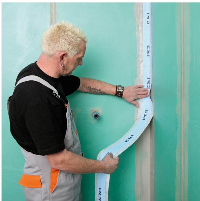
3. PCI Pecitape 120 mit PCI Lastogum Dicht in Eckfugen und Boden-Wand-Anschlüsse einkleben.
