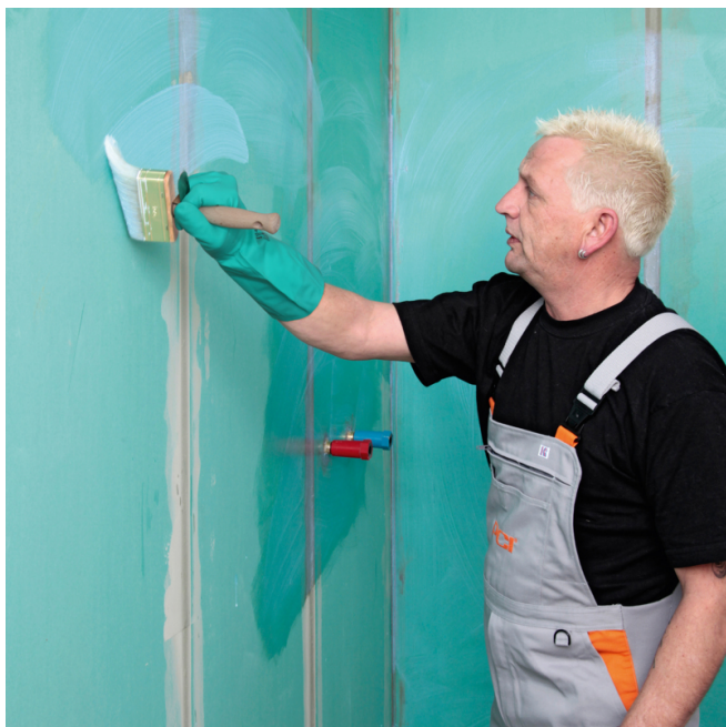
1. Grundieren: Saugende mineralische oder gipshaltige Untergründe und Gipskartonplatten mit PCI Gisogrund All-in-One grundieren.
