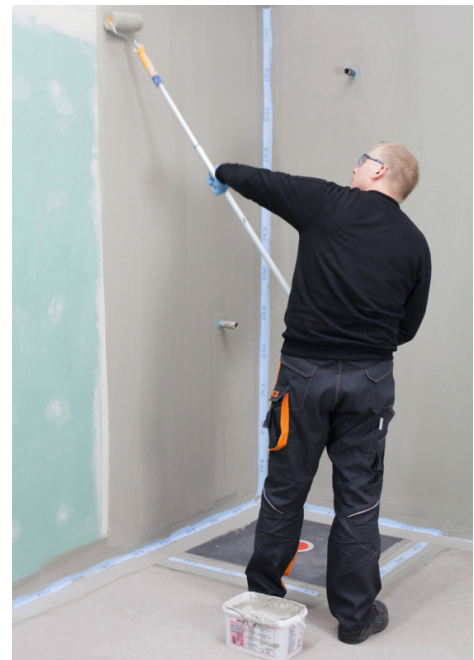
PCI Lastogum Dicht wird unverdünnt durch Rollen, Streichen oder Spachteln auf den Untergrund aufgebracht.
