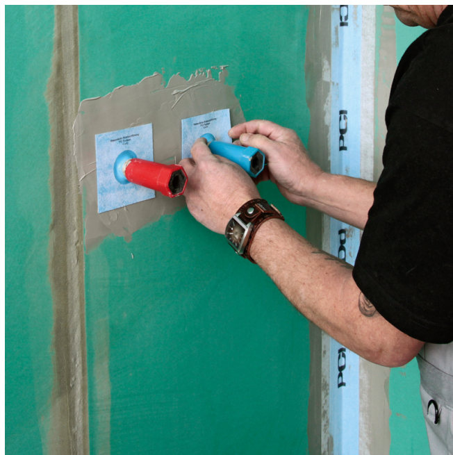
2. PCI Pecitape 10 x 10 über den aus der Wand herausstehenden Rohranschluss stülpen und mit PCI Lastogum Dicht verkleben.
