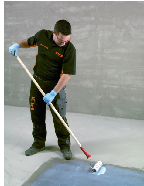
PCI Gisogrund All-in-One schützt vor zu schnellem Wasserentzug, verlängert die klebeoffene Zeit, verbessert die Haftung und vermeidet die Bildung von Schwundrissen.
