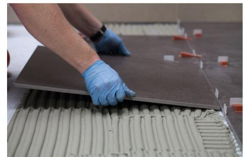
Mit PCI Flexkleber 200 lassen sich auch größere Formate standfest an der Wand sowie mit langer Verarbeitungszeit am Boden verlegen.
