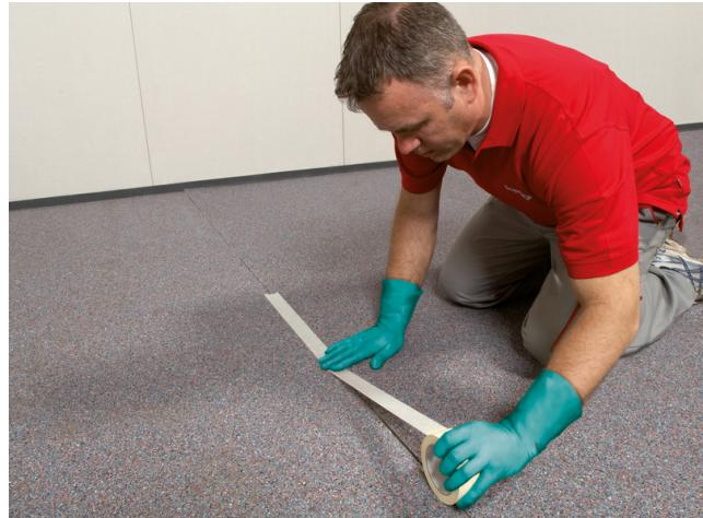
Zur Vermeidung von Mörtelbrücken (Körperschallbrücken) können die Stoße der Bahnen mit Klebeband überklebt werden.
