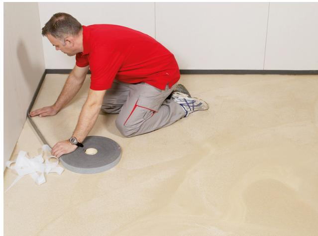
Um Schallbrücken zu vermeiden, sind vor Beginn der Fliesenverlegearbeiten Randdämmstreifen (z. B. Sopro RandDämmStreifen) je nach Belagsstärke anzudrehnen.
