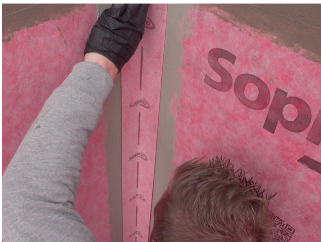
Das passgenau zugeschnittene Sopro AEB® Dichtband Flex (mit Falz) ohne Schlaufenbildung in die frische Klebeschicht einlegen und fest andrücken.
