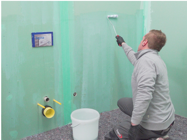
Saugende Untergründe mit Sopro Grundierung vorbehandeln.
