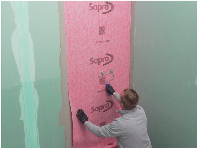
Die passgenau zugeschnittene Sopro AEB® Abdichtungs- und Entkopplungsbahn in die frische Klebeschicht einlegen und von der Mitte her fest andrücken.
