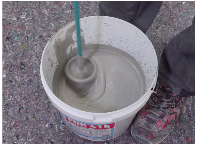
FDK 415: Flüssigkomponente vorgeben und mit Pulverkomponente maschinell anmischen. Alternativ: DSF RS im vorgegebenen Verhältnis mit Wasser anrühren.
