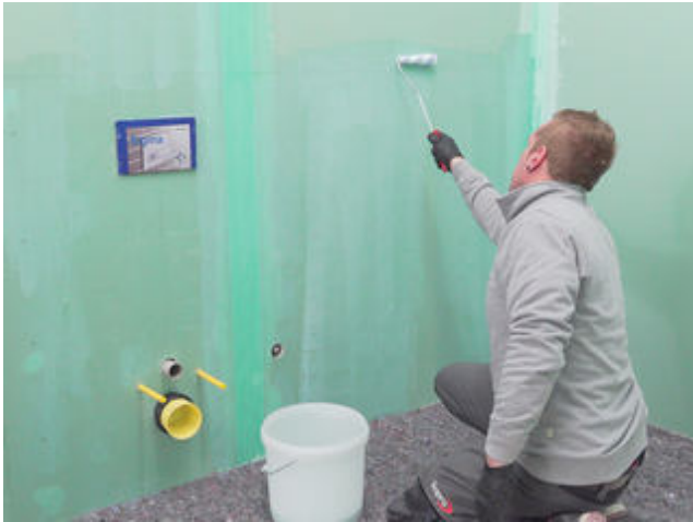
1 Saugende Untergründe mit Sopro Grundierung vorbehandeln.
