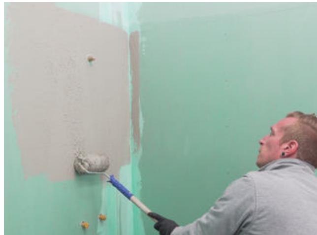
4 Sopro Fixier- & Dichtkleber oder Sopro DichtSchlämme Flex RS vollflächig aufrollen.
