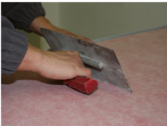
Mit Glättkelle oder Malerrollenbügel die Sopro AEB® plus andrücken und so abzustreichen, dass keine Lufteinschlüsse unter der Bahn verbleiben.
