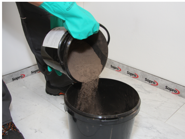
Sopro DF 10 zudosieren und maschinell anrühren.
