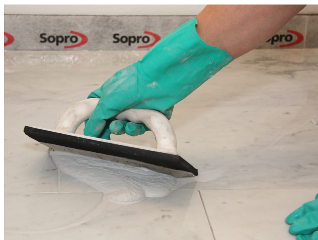
Einfugen von Sopro DF 10 in verarbeitungsempfindlichen Naturstein.
