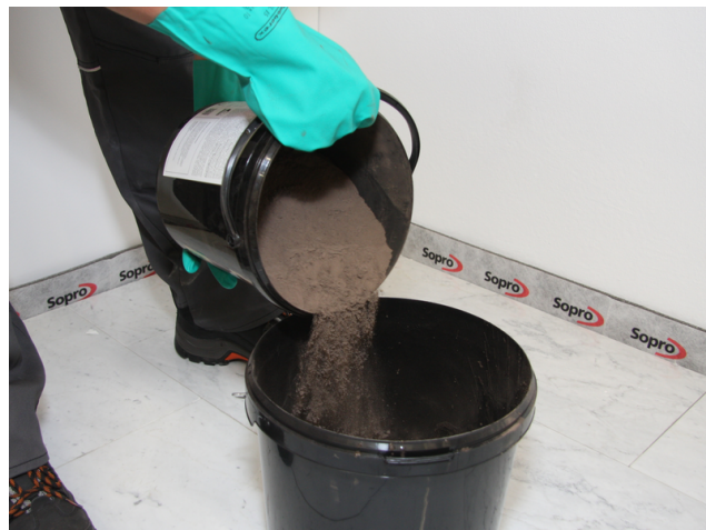
Sopro DF 10 zudosieren und maschinell anrühren.
