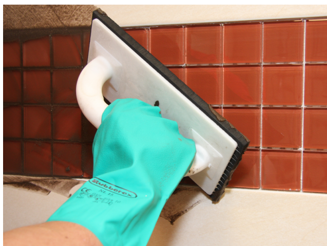
Einfugen von Sopro DF 10 in Glasmosaik.
