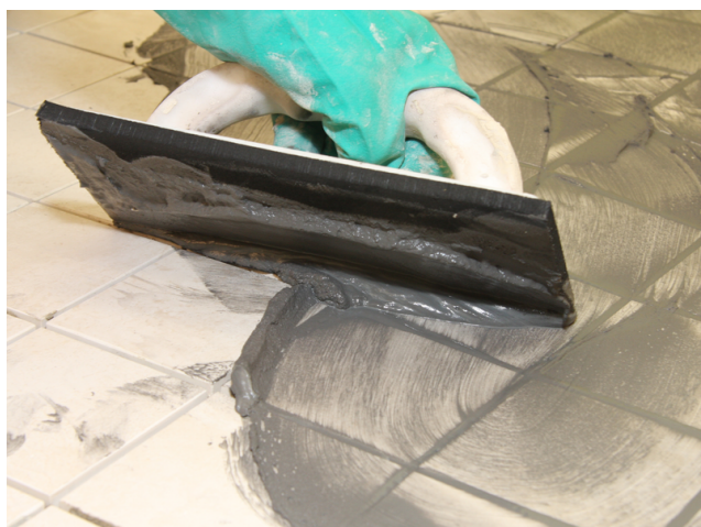
Einfugen von Sopro DF 10 in Feinsteinzeugfliesen.
