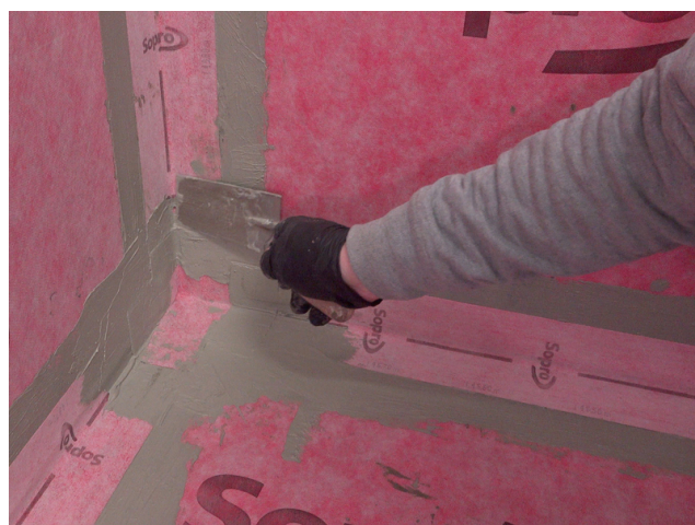
Abschlüsse des AEB® Dichtband Flex (mit Falz) werden im Anschluss mit Sopro Fixier- & DichtKleber oder Sopro DichtSchlämme Flex RS überarbeitet.
