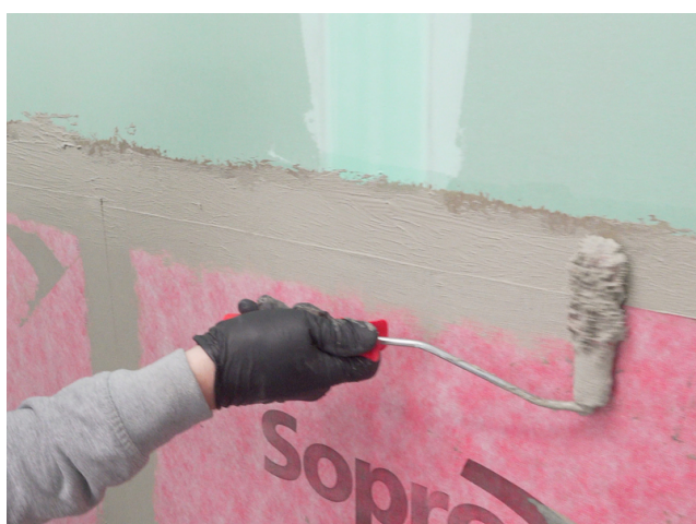
Die Abschlüsse der Sopro AEB® Ab dichtungs- und EntkopplungsBahn mit Sopro Fixier- & DichtKleber oder Sopro DichtSchlämme Flex RS überarbeiten.
