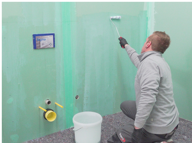
Saugende Untergründe mit Sopro Grundierung vorbehandeln.
