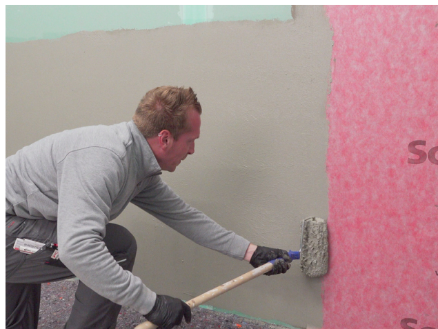
Die Überlappungen der Sopro Ab dichtungs- und EntkopplungsBahn ca. 5 cm mit Sopro Fixier- & DichtKleber oder Sopro DichtSchlämme Flex RS überarbeiten.
