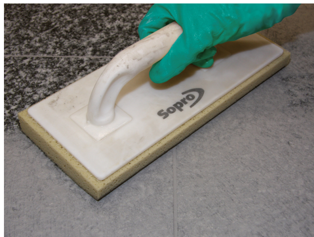
Abwaschen des Natursteinbelages nach ausreichender Standzeit der eingefugten Sopro Fugenmasse.
