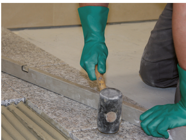
Einklopfen der Natursteinplatte und Überprüfung auf Ebenmäßigkeit.
