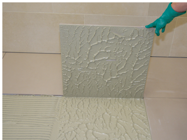
Optimale, nahezu hohlrautfreie Verlegung mit Sopro FKM XL möglich.
