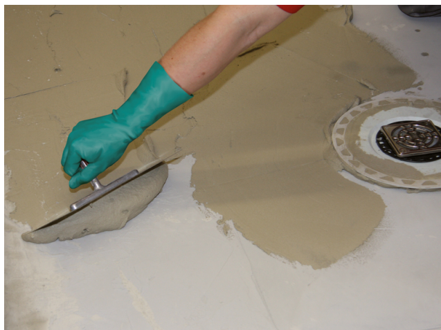
Für das Aufbringen einer partiellen Gefällespachtelung ist zuvor eine Kontaktschicht mit Sopro FKM XL aufzuziehen.
