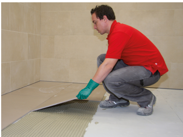
Großformatiges Feinsteinzeug einlegen und ausrichten. Fugennetz
