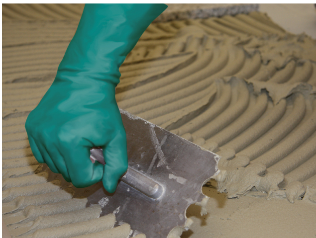
Aufziehen des Sopro FKM XL in Mittelbettkonsistenz mit einer Mittelbettkelle auf die vorbereitete Kontaktschicht.
