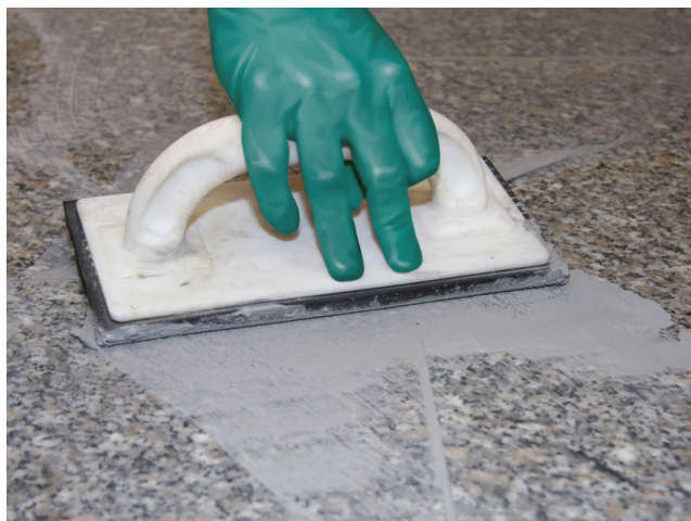
Verfugung des verlegten Natursteinbelages mit einer Sopro Fugenmasse (z.B. Sopro DF 10 DesignFuge Flex, Sopro Brillant PerlFuge).
