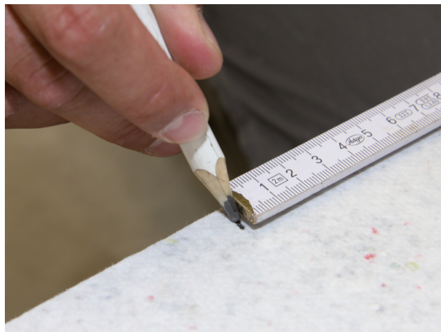
Anriss zum maßgenauen Schneiden einer Sopro FliesenDämmPlatte.
