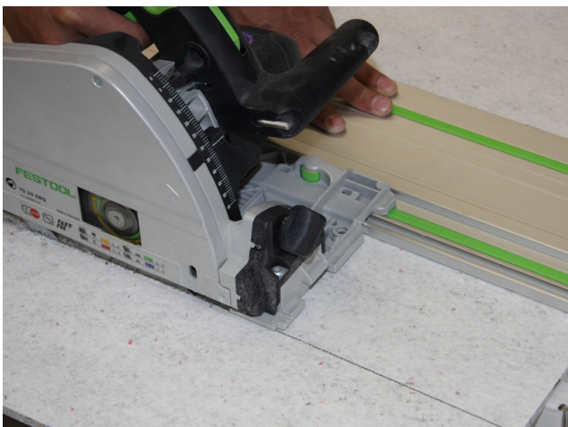
Für das Zuschneiden der Sopro FliesenDämmPlatte ist z. B. eine Handkreissäge zu verwenden.
