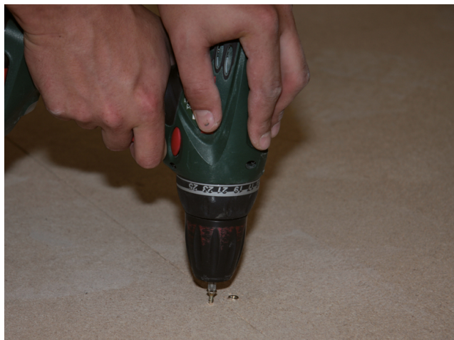
Vor der Verlegung der Sopro FliesenDämmPlatte auf z. B. Spanplatten, sind die Spanplatten fest anzuschrauben.
