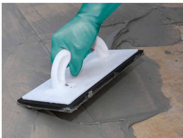
Einfügen einer Sopro Fugenmasse (z. B. Sopro DF 10® Design- Fuge Flex oder Sopro FlexFuge FL) nach Erhärtung des Sopro Flexklebers
