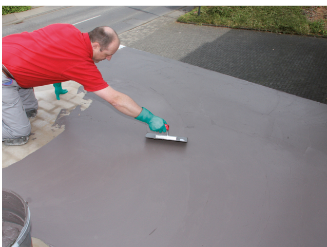
Glätten der Sopro TurboDichtSchlämme 2-K mittels Glättkelle.
