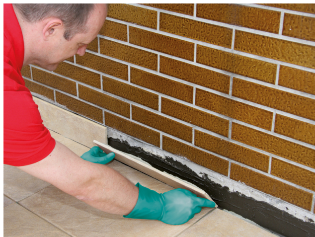
... und Ansetzen der Sockelfliese.
