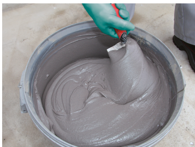
... bis eine verarbeitungsgerechte, cremige Konsistenz erreicht ist.
