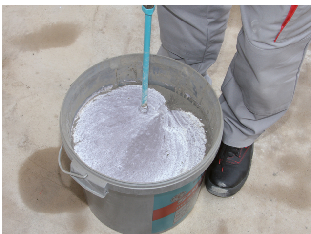
Homogenes Anmischen der zwei Komponenten ...
