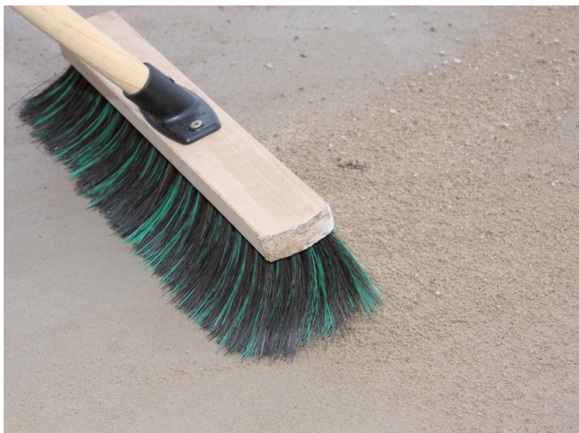
Säubern des vorbereiteten, ebenmäßigen Untergrundes.
